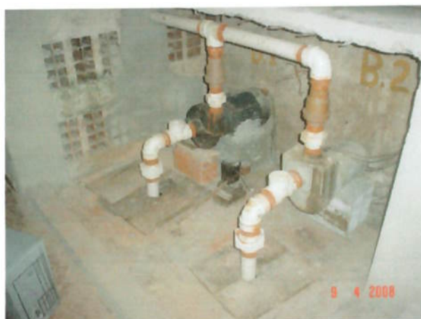
Figura 6 - Fossa do 2º Subsolo
