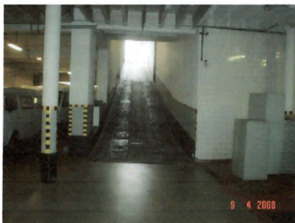
Figura 12 - Rampa do 2º subsolo
