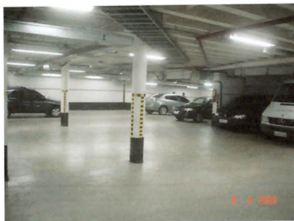
Figura 10 - Veículos estacionados no 1º subsolo
