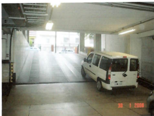
Figura 8 - Rampa do 1º subsolo
