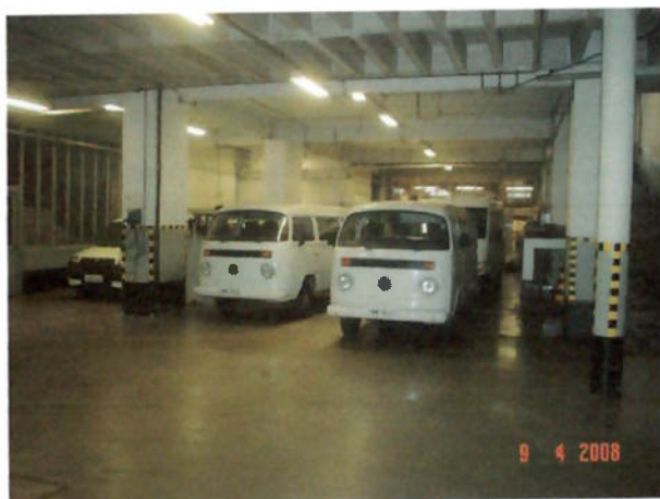
Figura 11 - Veículos estacionados no 2º subsolo
