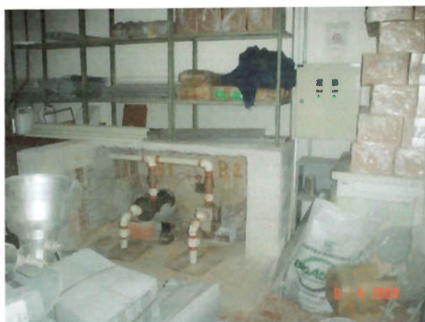
Figura 7 - Acúmulo de materiais no local da fossa
